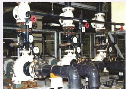
名古屋上下水道局 下水処理場
