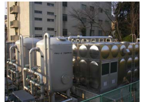
金沢大学付属病院マンガンろ過設備
